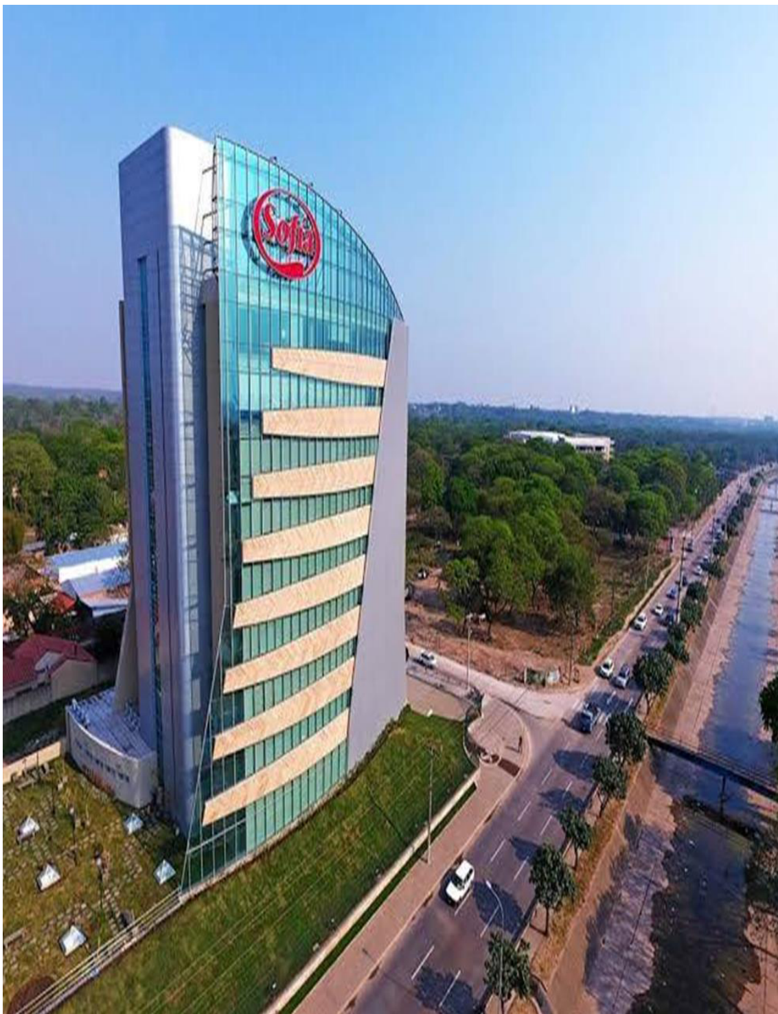
Edificio Corporativo Central: Vista aérea de la casa matriz tecnológica y sostenible de Sofia Ltda., ubicada en el Cuarto Anillo de la ciudad de Santa Cruz de la Sierra, Bolivia.
