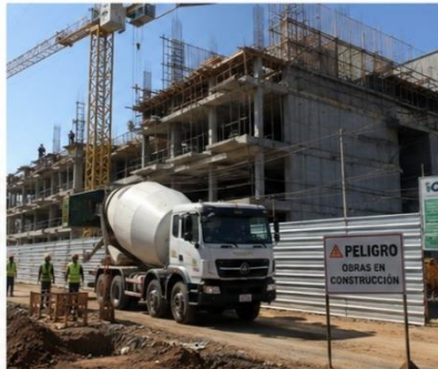
Foto 5. Zona de construcción – Uso de maquinaria pesada y equipos generadores de ruido.
