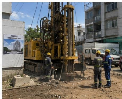
Foto 5. Perforación y obras civiles – Generación de ruido por maquinaria pesada.
